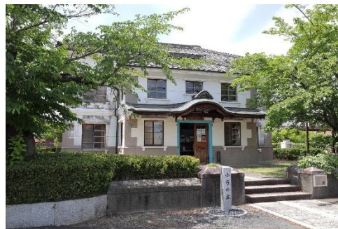
【犬山市羽黒地区】旧加茂郡銀行羽黒支店復原施設（小弓の庄）
